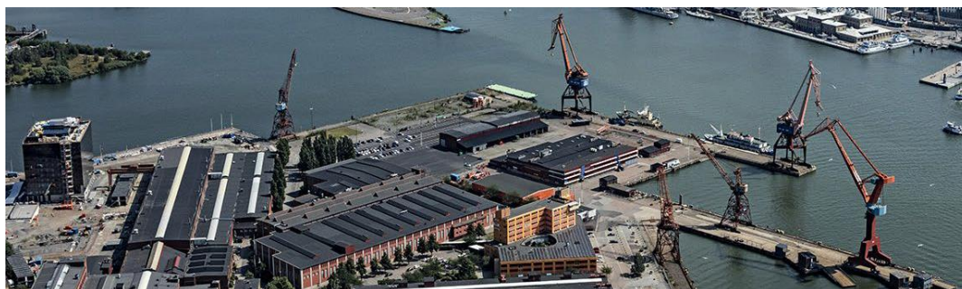
Figur 31. Flygfoto över Lundbyvassen med bevarade verkstadsbyggnader och kranar. Källa Göteborgs Stad.
